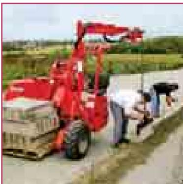
La pose des bordures et caniveaux préfabriqués en béton est simple et s'effectue selon le Fascicule 31 du CCTG. Elle permet d'intégrer les contraintes de flexibilité des chantiers :
