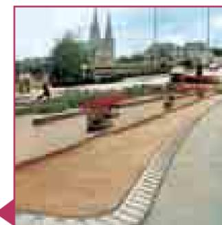
Les bordures basses en béton préfabriqué peuvent comporter des cannelures ou rainures provoquant un avertissement sonore pour les conducteurs qui les franchissent.
