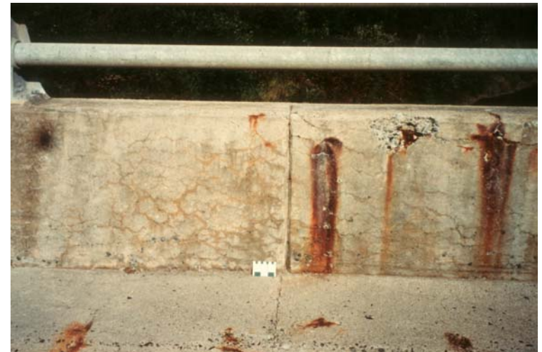
Taches de rouille Rust Staining
