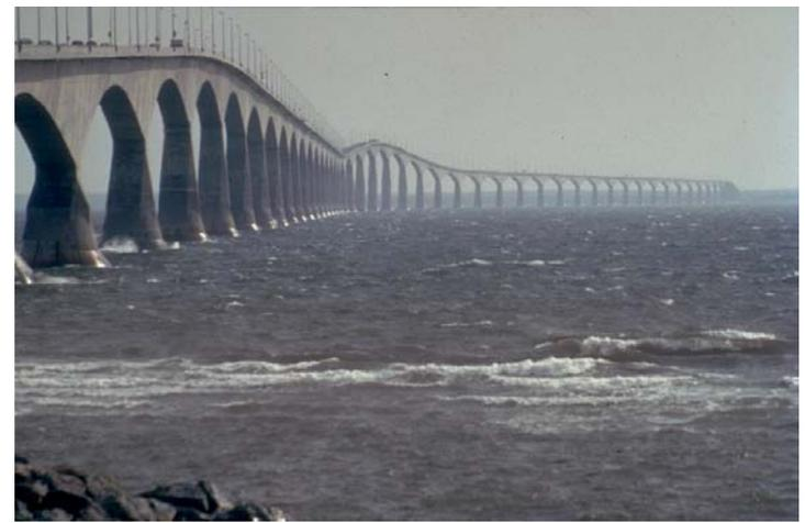
Confederation bridge, Canada: ciment+FS pré-mélangé +cendres volante ajouter à stage de fabrication du béton - pour augement durabilité, ameilorer pompabilité, reduire chaleur, meilleur resistance
